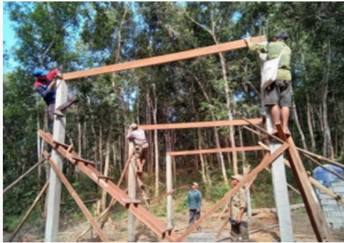
○サー村での加工場建設の様子
