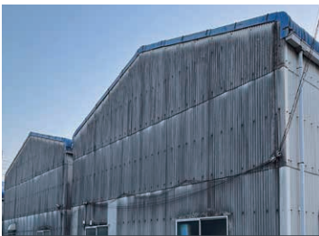
築年数の古い工場・倉庫
