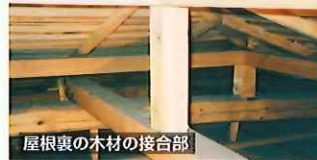
手抜き梁の接合部
