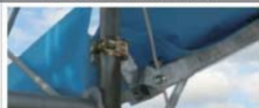
クランプタイプ片側上部金具 シートの折り返し
