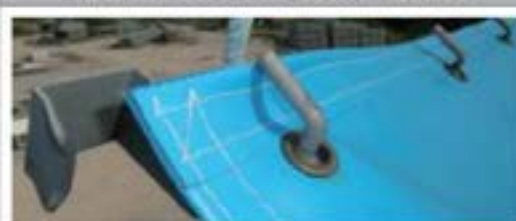
面板とフレームはフック留め、断熱材は禁止金具で留める
