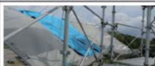
円弧形対応シート 足場内でシート朝顔を開けば設置できる
