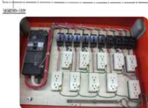
MPL 変電用 (動力・電灯)
